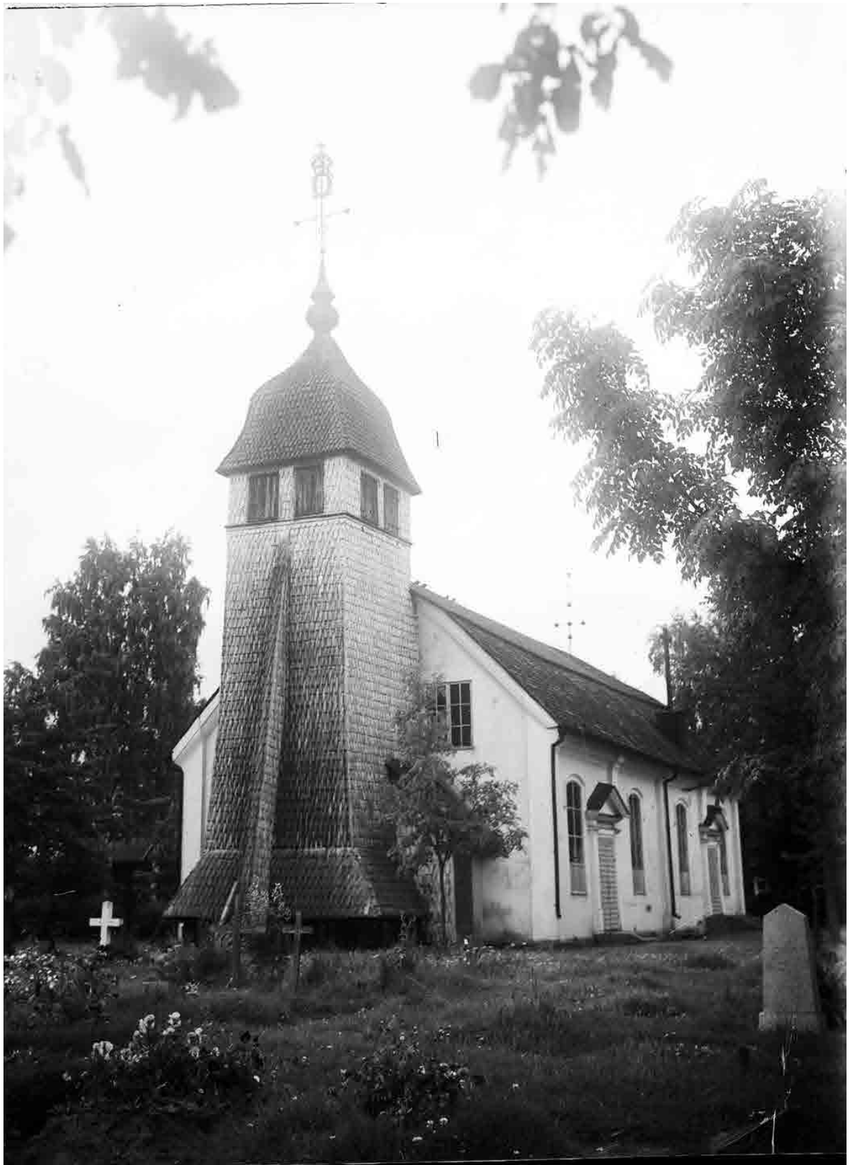
Fotografi över Djura kyrka och kyrkogård från tidigt 1900-tal. Det allmänna varv som låg framför kyrkan innan utvidgningen under 1930-talet syns med sina träkors. Markytan är gropig och ojämn och några markerade gravrader eller gångvägar framgår inte. Foto: Dalarnas museums bildsamling.
