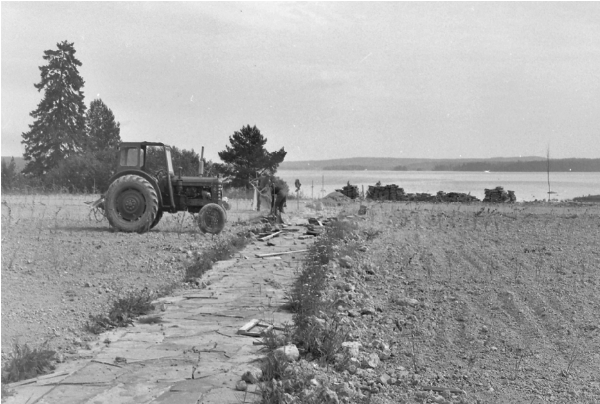
En plattgång av asymmetrisk sten läggs i öst-västlig riktning ner mot Bäringen. Källa: Privat bildsamling.
