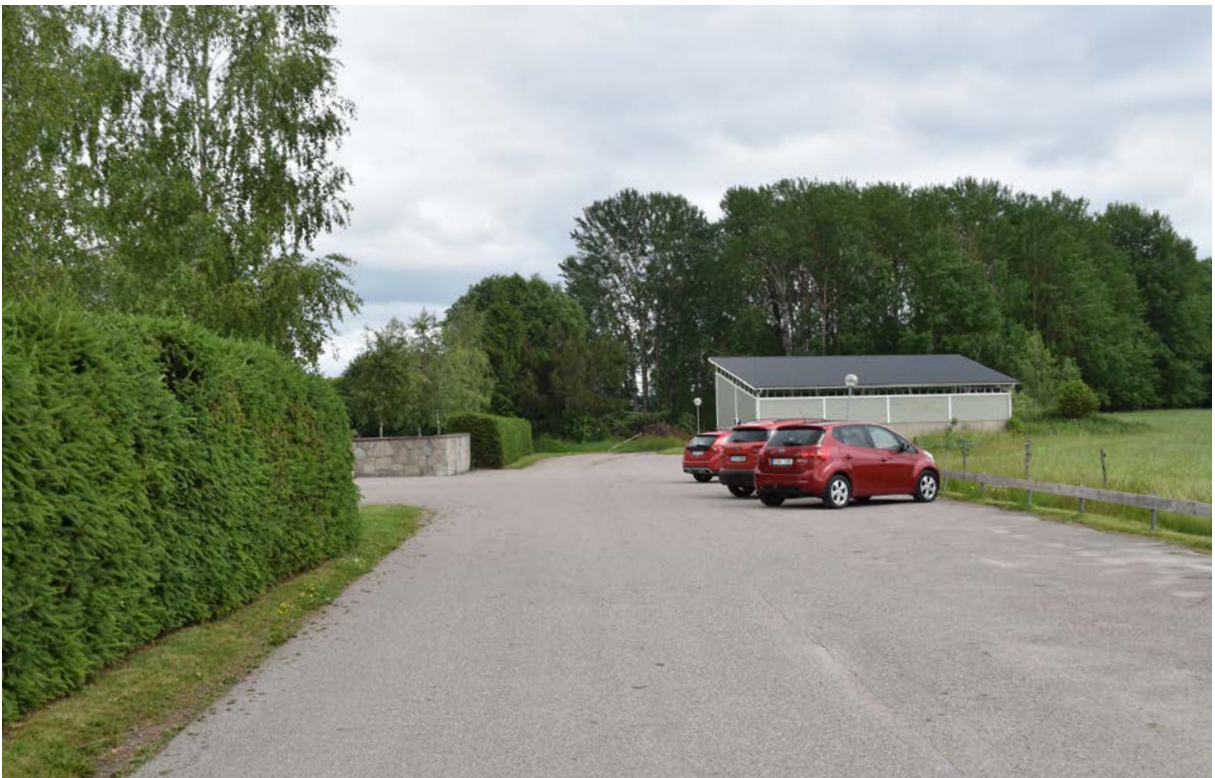
Utanför södra entrén finns besöksparkering och öster om denna ett kallförråd och upplagsytor.
