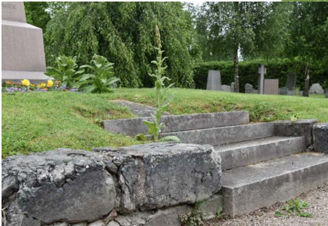
Slaggsten och trappa av krysshamrad granit.
