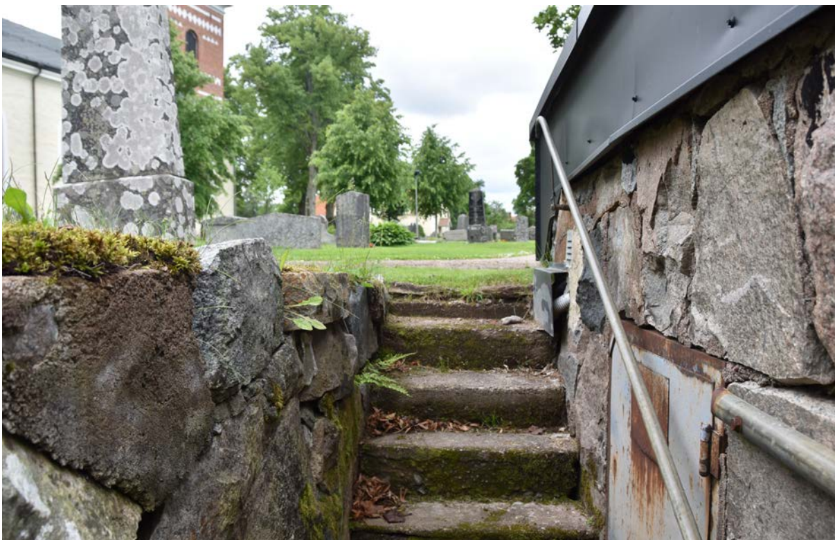
Ekonomibyggnad för elcentral med fasad av natursten och gjuten trappa i Gamla kyrkogårdens nordöstra hörn.
