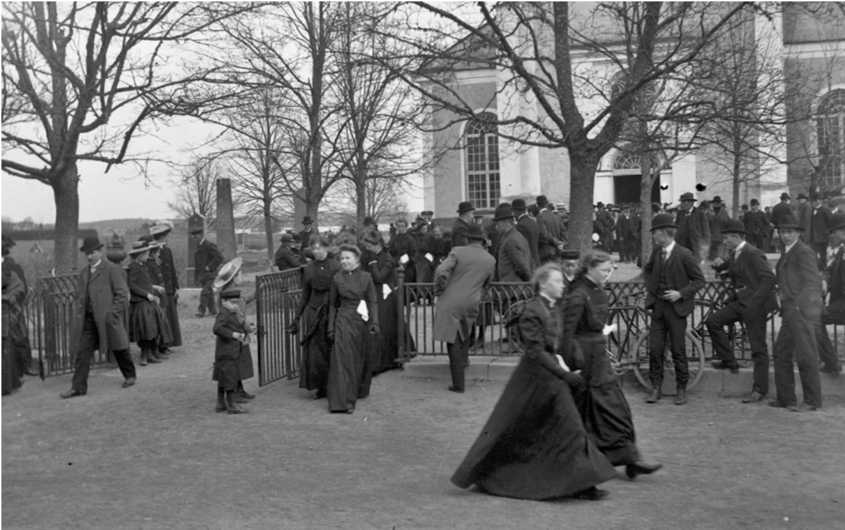
Kyrkbacken omkring 1910. Gjutjärnsstaket i nygotisk stil på släthuggen stensockel i väst. Det idag befintliga gjutjärnsstaketet är tillkommet i olika etapper under lång tid, från sent 1800-tal till 2007. Källa: Privat bildsamling.
