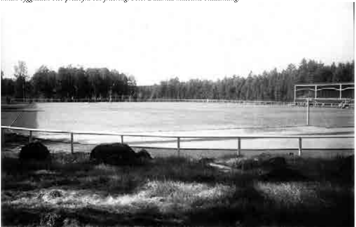
Tansvallen invigdes 1934. Området avsattes redan 1916 till idrottsplats men det tog några år innan anläggningen var komplett. Foto: Dalarnas museums bildsamling.
