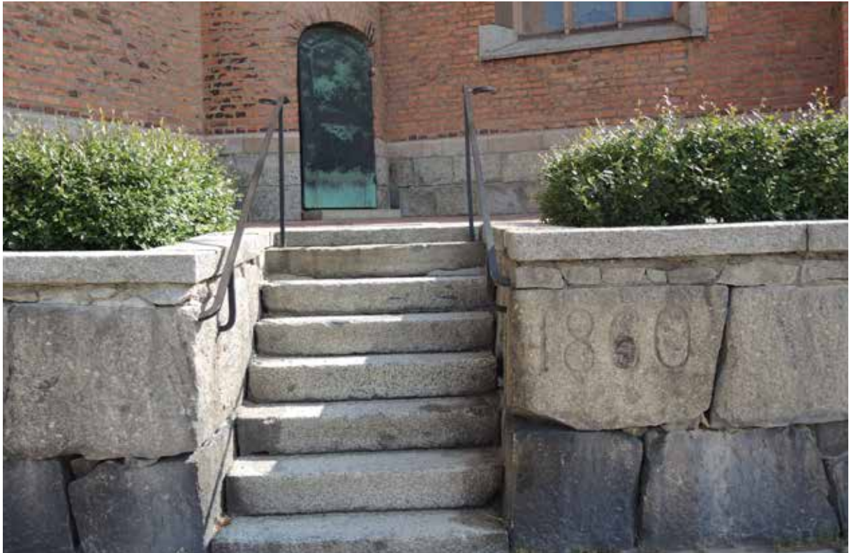
Intill kyrkans entré finns en trappa som leder upp från Stora torget tillsammans med muren från 1860, med tillhörande inristning.
