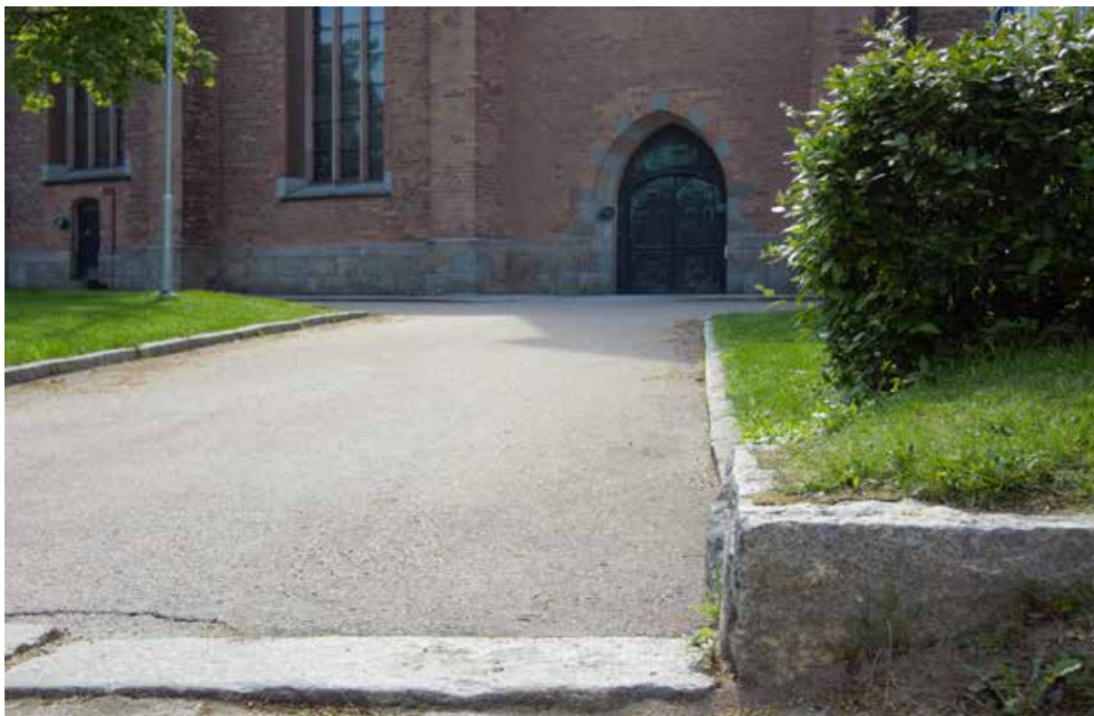
Ovan: Kyrkogårdens norra infart med asfalt och avlastningsyta. Oxbärshäcken omgärdar hela kyrkogården.
