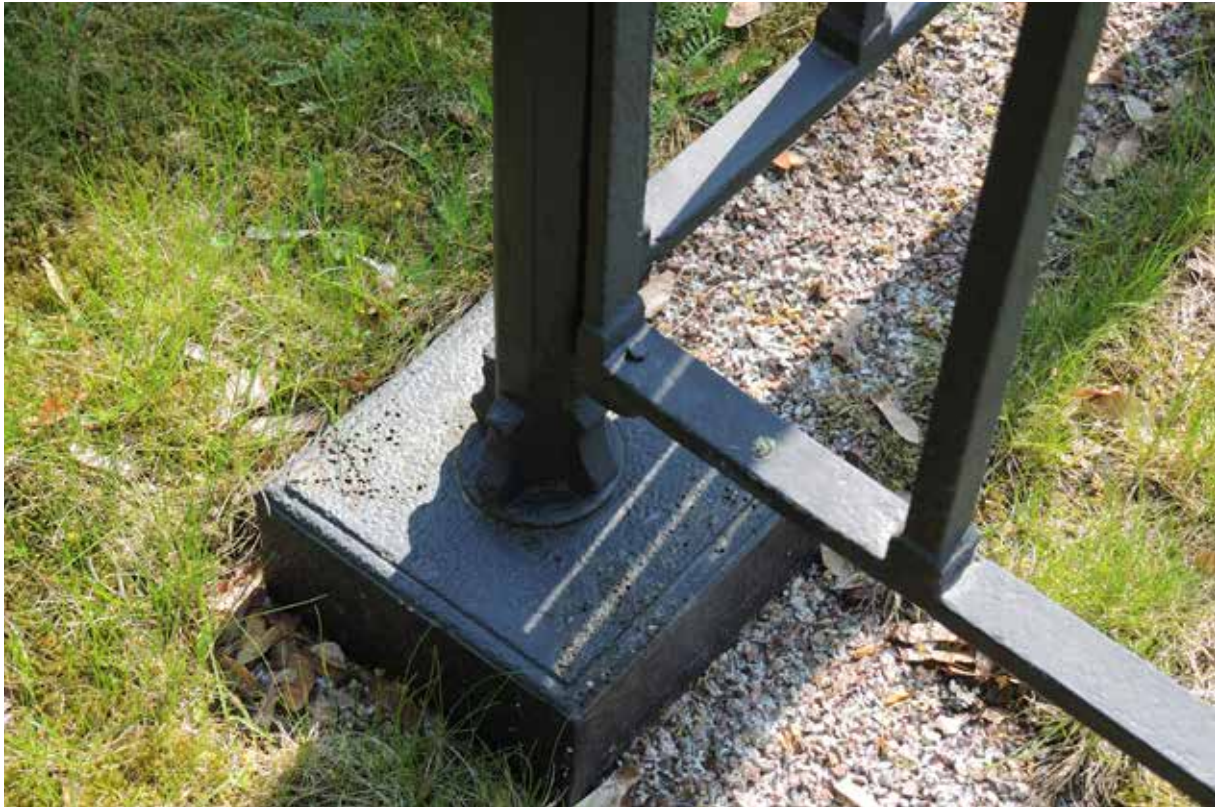
Detalj av omgärdning i gjutjärn. Granit eller kalksten var vanligt som grund till staketen av gjutjärn. På riktigt påkostade gravvårdar kunde grunden dock, som här, bestå av gjutjärn.
