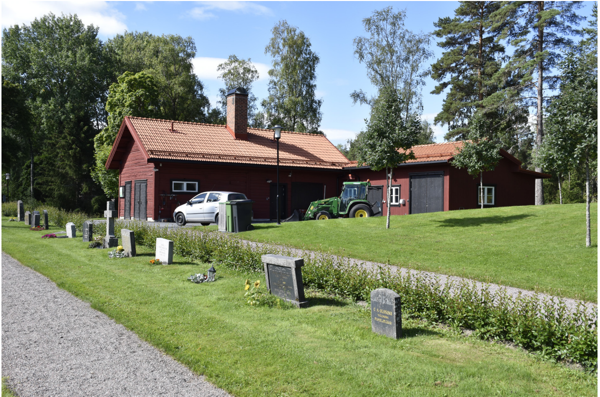
Ekonomibyggnaderna vid Aspeboda kyrkogård står i vinkel väster om kyrkan. 1990 tillkom verkstadsdelen mot nordväst.
