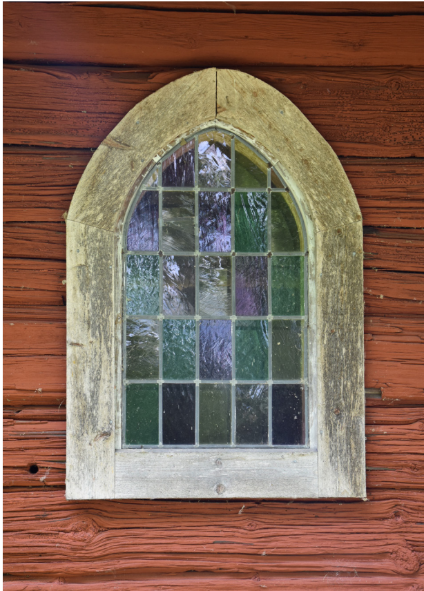
Närbild på fönster på östra fasaden av boden som troligen tillkommit efter det att byggnaden flyttats.
