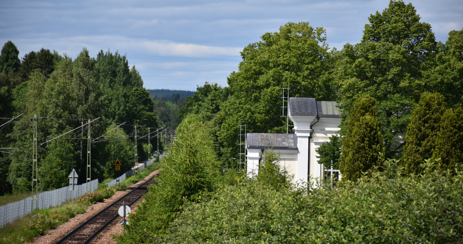
Järnvägen löper längs hela kyrkogården i väst, strykandes strax bakom knuten på begravningskapellet.
