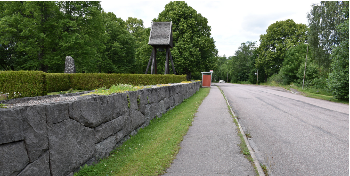
Älvsbrovägen som löper längsides med kyrkogårdsmuren.
