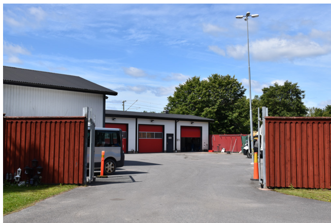
Utbyggnad av servicehuset med garage.
