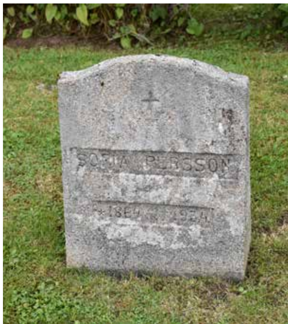
Betong är ett förekommande material på Nås kyrkogård och finns på ett flertal av de allmänna varven.
