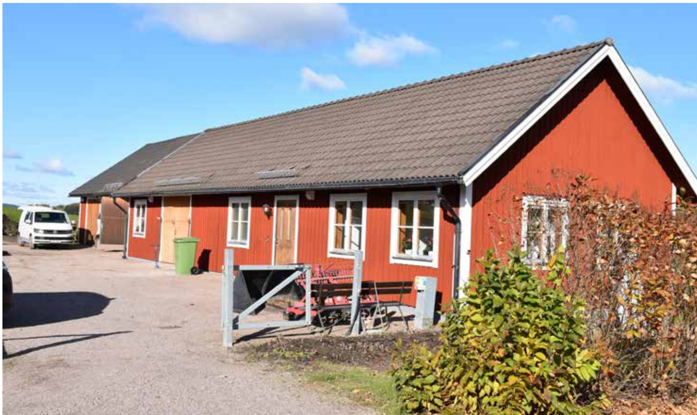
Servicebyggnader norr om den meller- sta kyrkogården.
