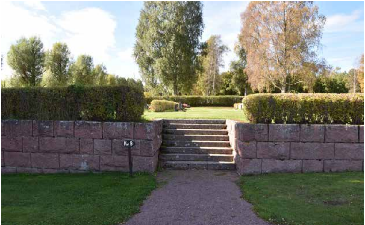
Terrassmur och trappa av orsasandstensblock på den del av Orsa nya kyrkogård som tillkom vid utbyggnad efter ritningar av arkitekt Viking Göransson under 1940-talet.
