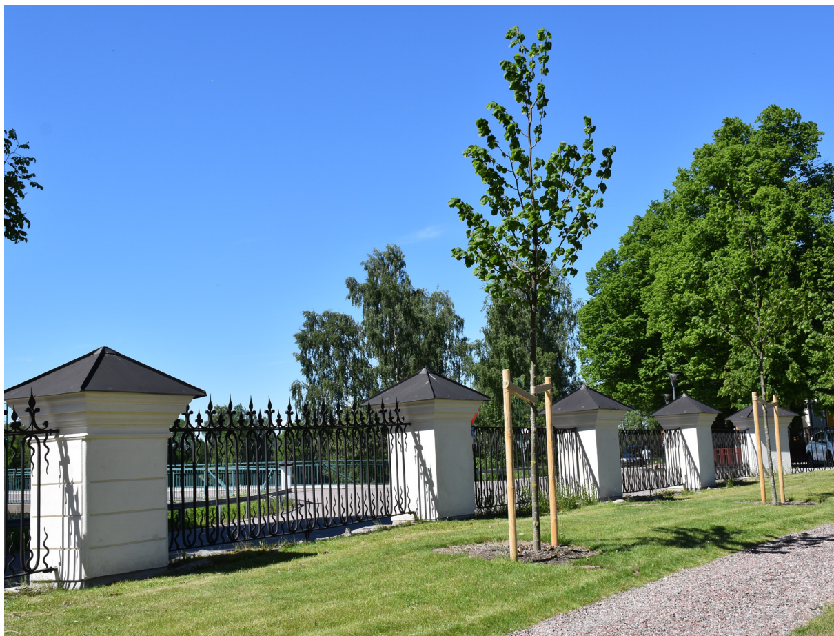
Kyrkogårdens äldsta delar omgärdas av ett järnstaket på en låg stengrund med vita stenpelare med jämna mellanrum. Gångarna i området är grusade.
