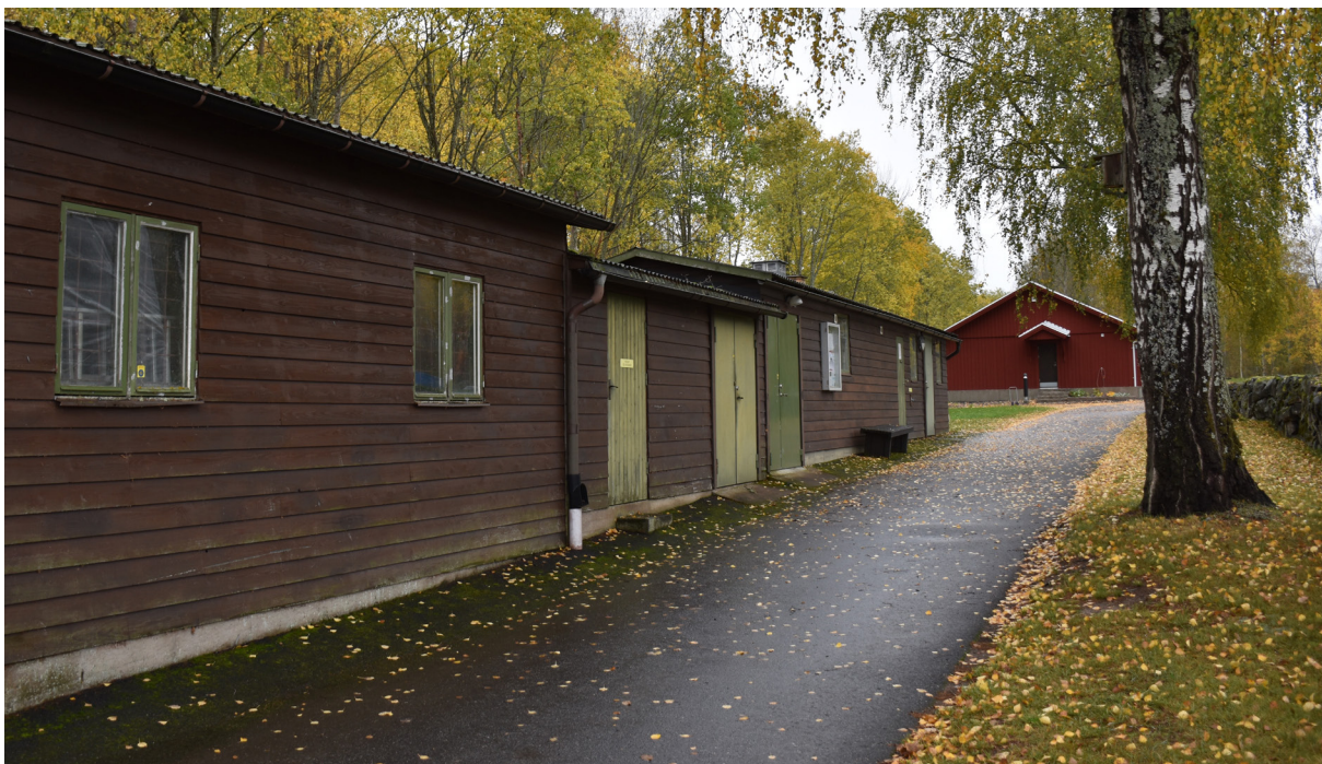
Äldre ekonomilänga i brunt och nybyggd ekonomibyggnad i rött.
