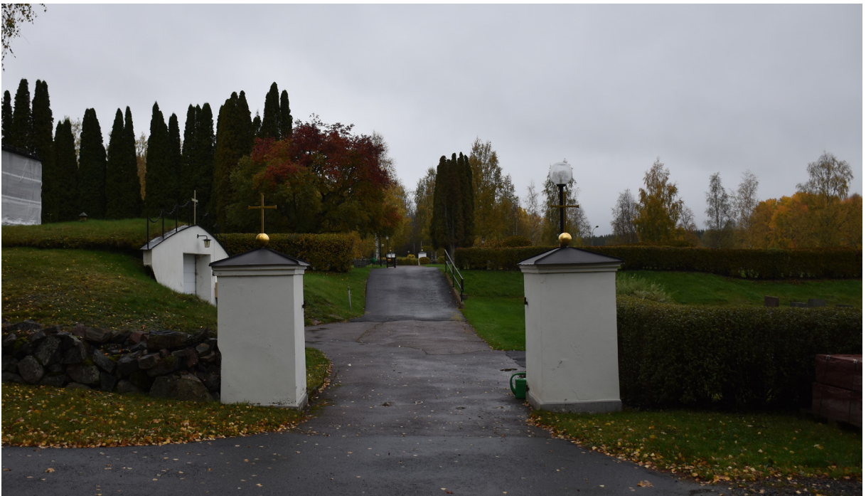
I en sluttning innanför södra ingången finns ett bårhus med putsad gavel mot öst, krönt av ett förgyllt kors.
