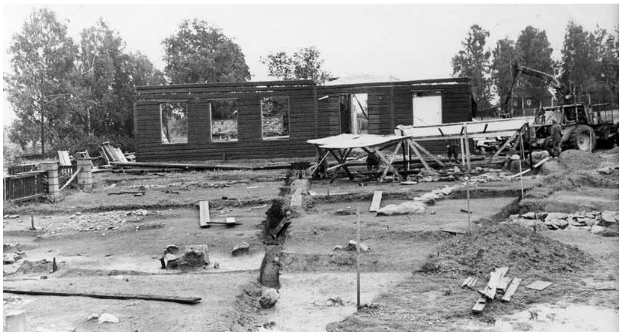
Rivningen av Ovangårdarnas skola och utgrävningen av resterna från Dalsby kapell med sin kyrkogård 1973–74. På platsen för bilden finns i dag en tunnel under riksväg 70. Bildkälla: »SK TB2337 - rivning av byggnad«, Sätters kommun, hämtad 11 december 2019, https://sk.kulturhotell.se/items/show/1123 .
