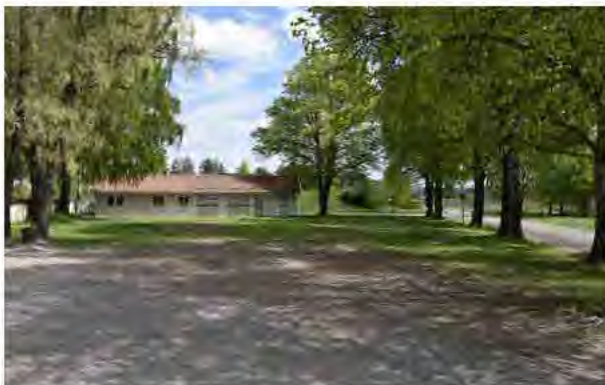
På platsen för vaktmästarbostadens tidigare placering finns idag bara ekonomibyggnaden kvar.
