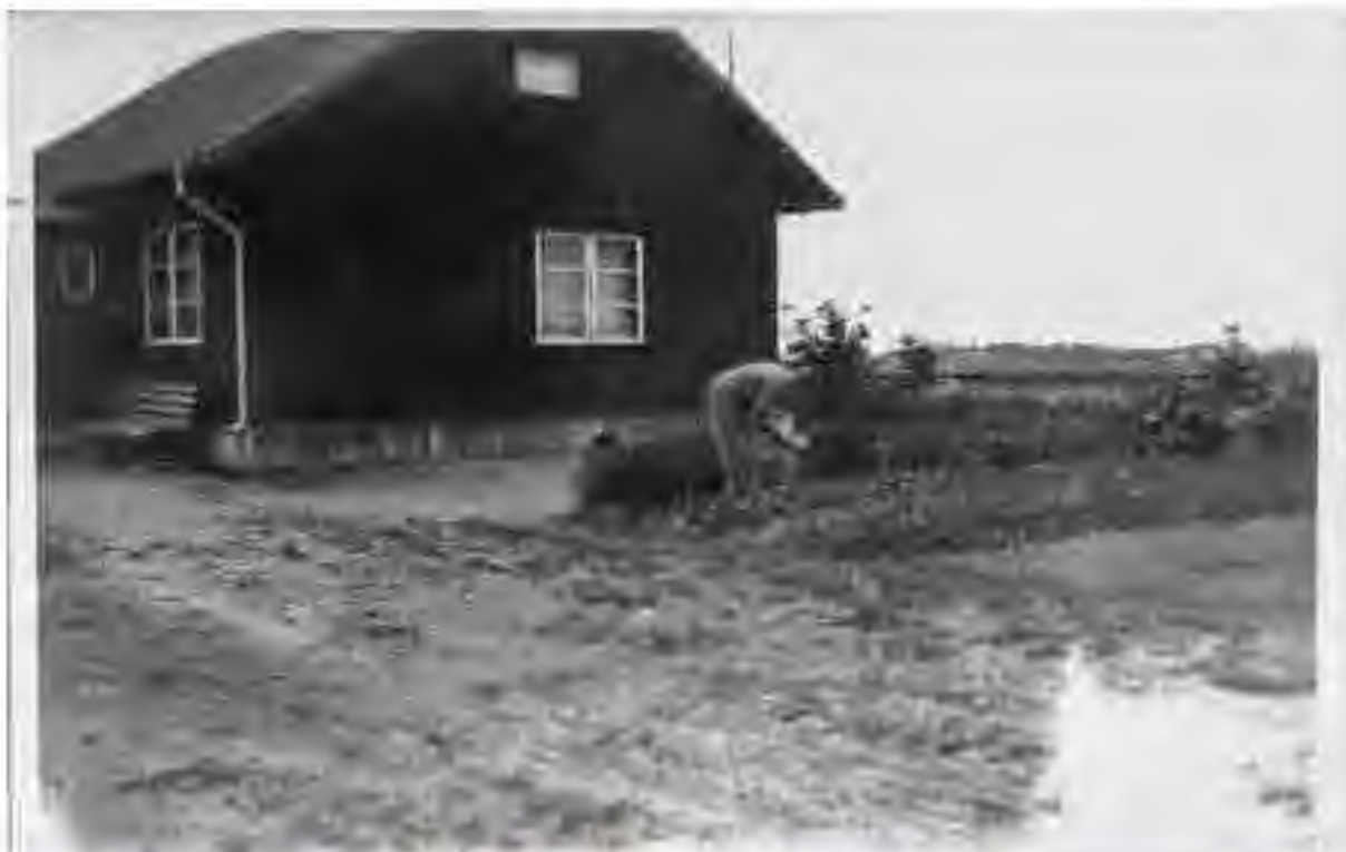
Vaktmästarbostaden vid Norra griftegården. Till huvudhuset hörde en ekonomibyggnad samt en köksträdgård. Byggnaden revs i början av 2000-talet. Foto: Stora Tuna pastorat.
