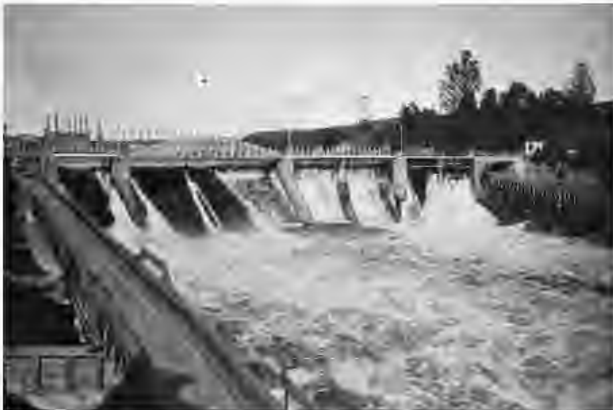
Bullerforsens kraftstation, den tredje kraftverksanläggningen som byggdes för att generera ström till den växande industrin. Foto: Dalarnas museums bildsamling.
