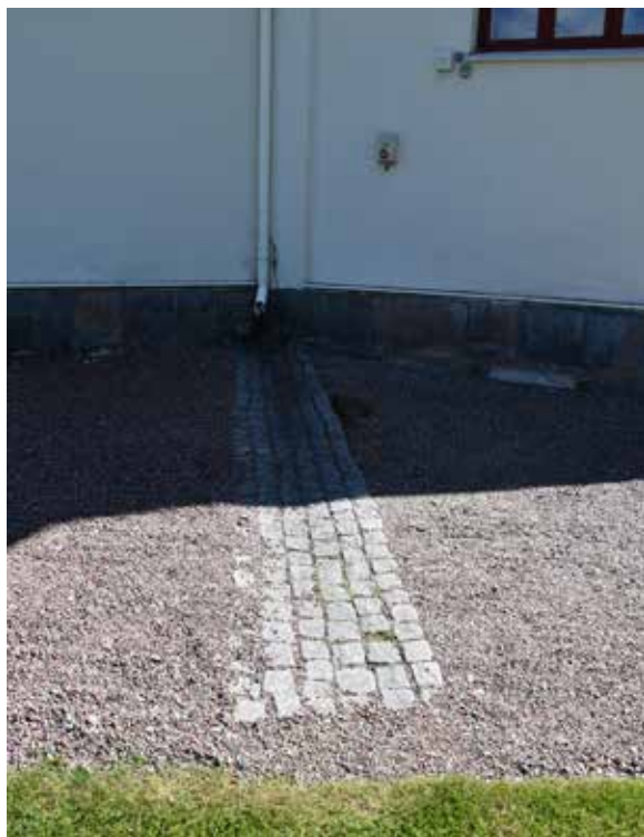
Till vänster syns en stensättning med natursten vid bisättningshuset från 1950-1951. Till höger kullerstensbelagd vattenavrinning vid kyrkobyggnaden.
