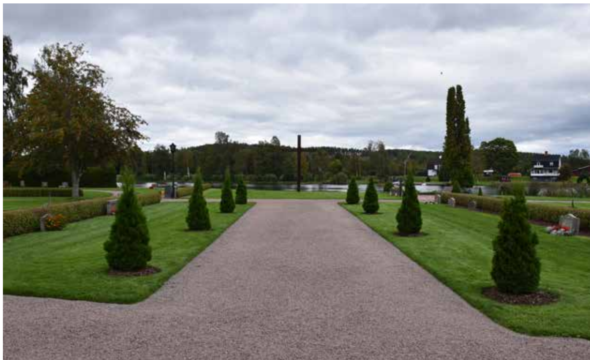
Vy från griftegårdens ingång. Anläggningen ger ett monumentalt intryck med symmetriska gravrader och påkostad modernism närmast mittaxeln. Korset på bilden markerar en minneslund, men där fanns ursprungligen ett gravkapell.
