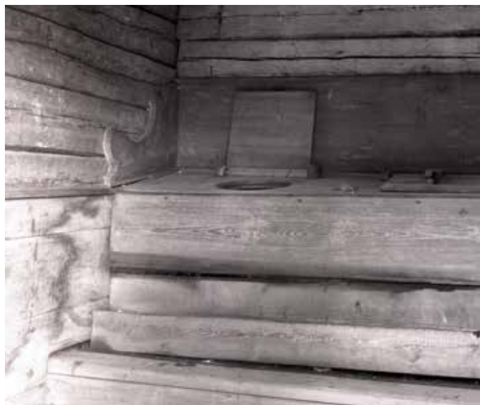
Interiör på dass i Gamla Staberg, Vika-Hosjö. Fjöl med åtminstone två sitsar. Lägg märke till de fasta dasslocken och det profilerade avslutet mot väggen. Foto: Karl-Erik Forsslund.
