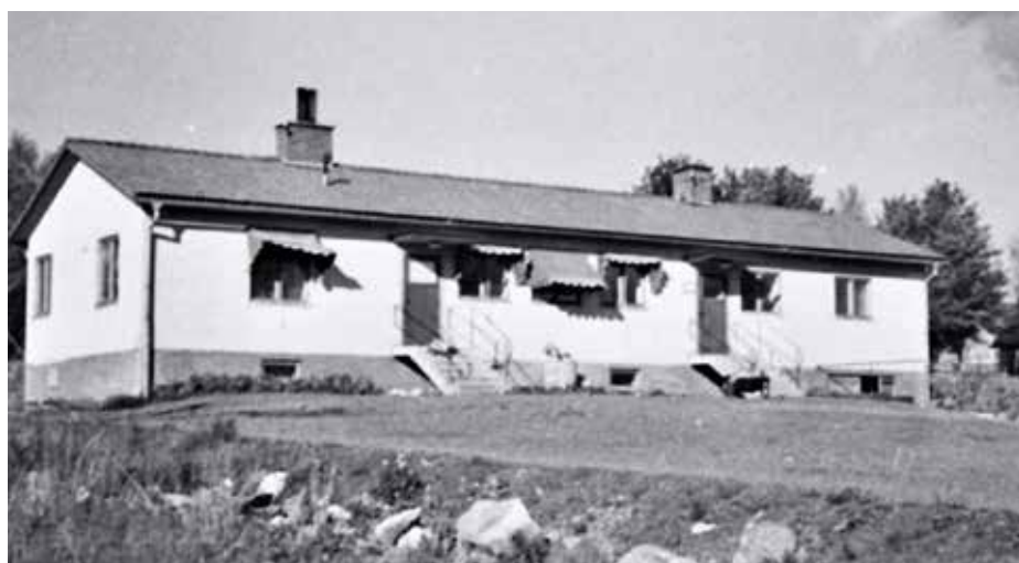
Tvättstugan i Vintjärn rymde även byns bastu. Byggt 1944. Foto: Okänd
