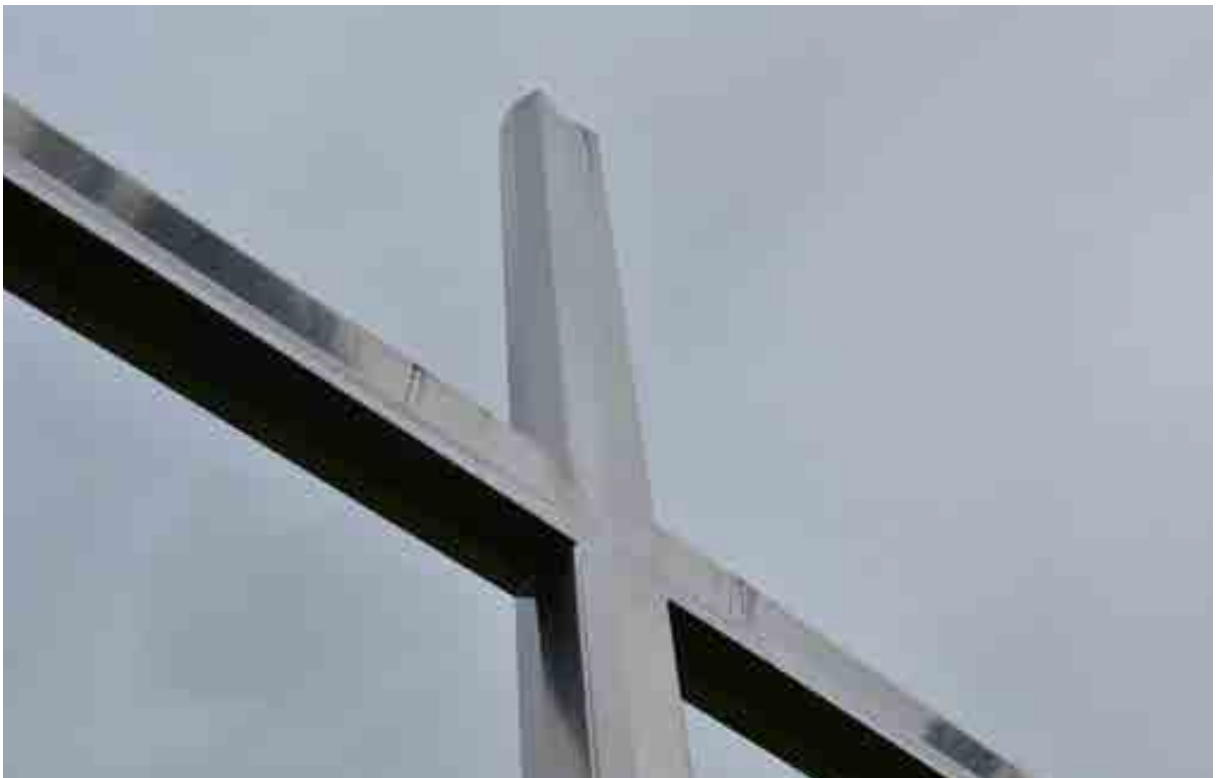
Korset är av rostfritt stål.
