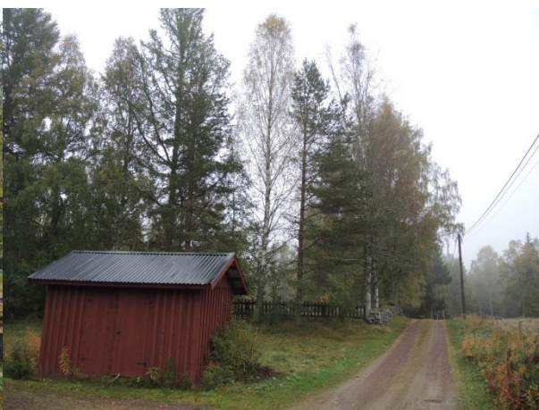
Ekonomibyggnaden intill parkeringen norr om begravningsplatsen.
