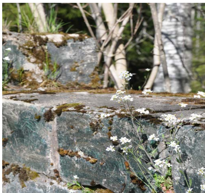
Slaggtegelmuren som tillkom 1967 och omgärdar begravningsplatsen på tre sidor.
