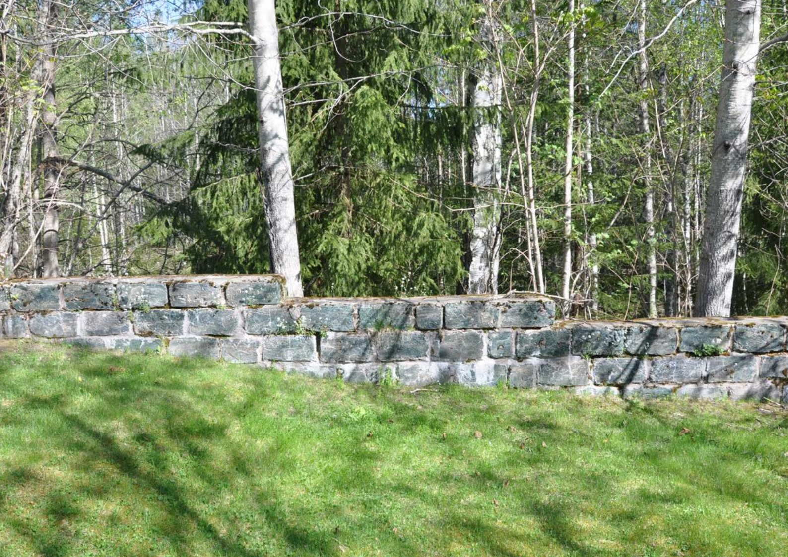
Den omgärdande muren i slaggtegel från 1967. Teglet togs tillvara i samband med rivning av ett lokstall.
