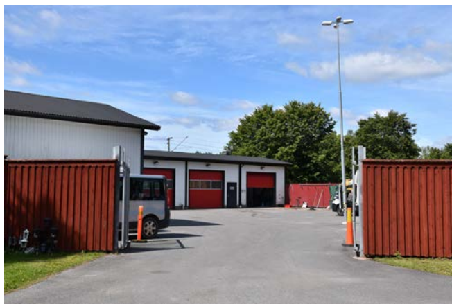
Utbyggnad av servicehuset med garage.
