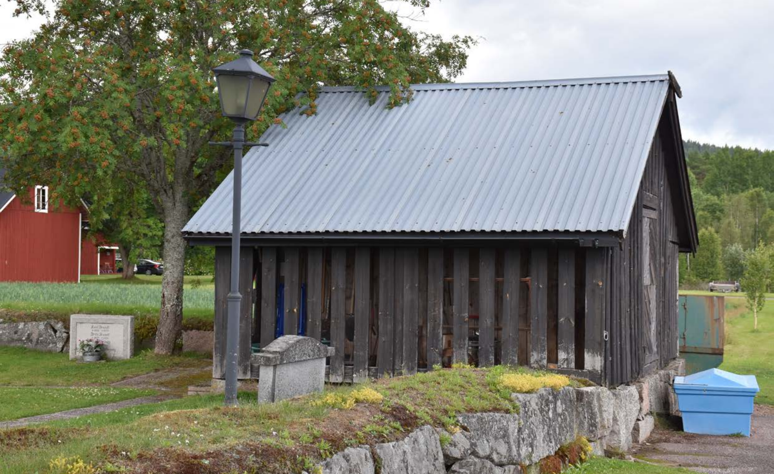
Förrådsboden i kyrkogårdens östra hörn, vilandes på massiv stengrund som matchar kyrkogårdsmuren. Exempel på parklykta ses till vänster i bild.
