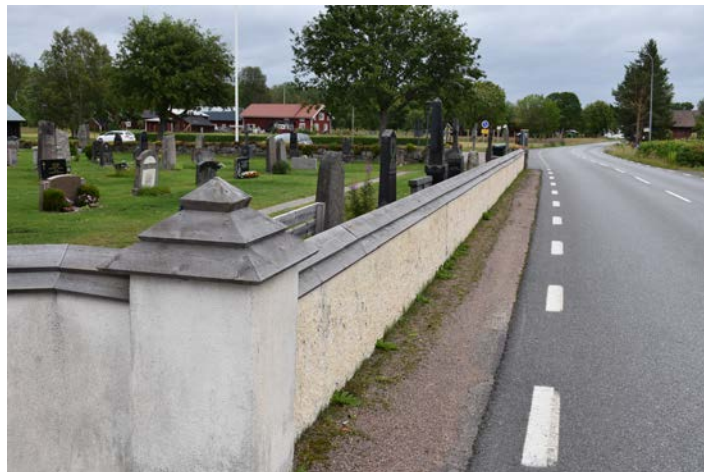
Spritputsad tegelmur ut mot vägen.
