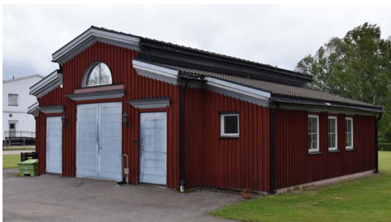
Garage och servicebyggnad intill parkeringen i nordväst.
