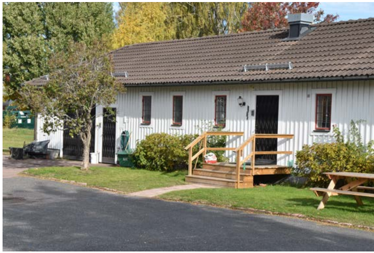
Personalbyggnaden ut mot parkeringen.
