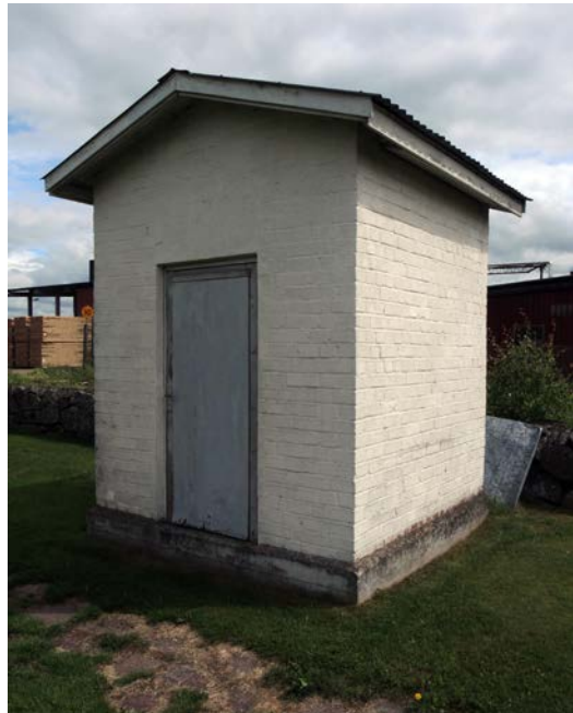
Äldre elcentral intill järnvägen på område I.
